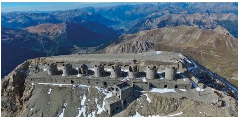
Forte Chaberton, cima Monte Chaberton 3.130 m.s.l.m.
